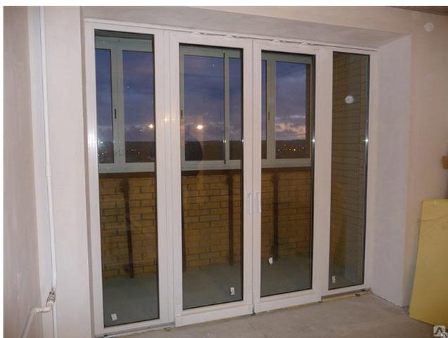
Рис. 3. Установка раздвижных витражей
