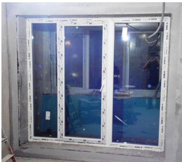
Рис. 4. Установка распашных витражей
