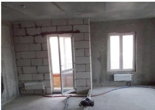
Рис. 5. Противопожарный простенок
